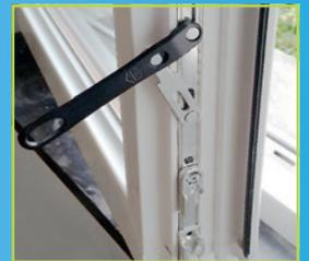
Système de fermeture renforcé du vantail secondaire
